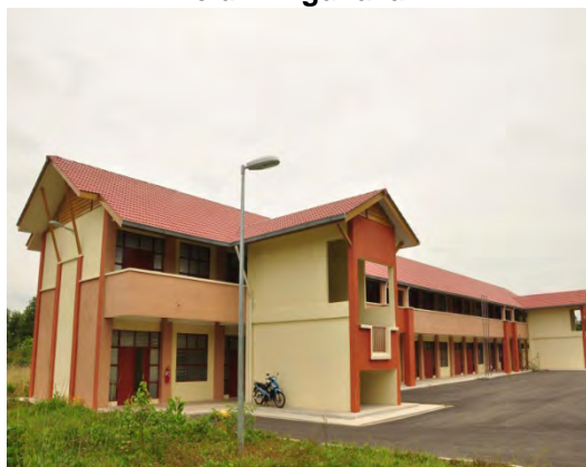
Gambar 3.6 Bangunan Siap Yang Masih Belum Digunakan
