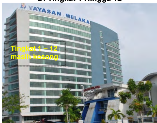
Gambar 4.7 Bangunan Yayasan Melaka Yang Kosong Di Tingkat 1 Hingga 12
