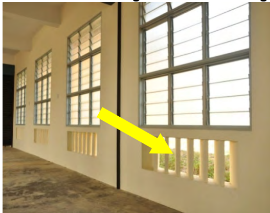
Gambar 3.24 Lubang Laluan Udara Yang Luas Di Bahagian Bawah Tingkap
