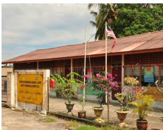
Gambar 3.1 Bangunan Sekolah Sedia Ada
