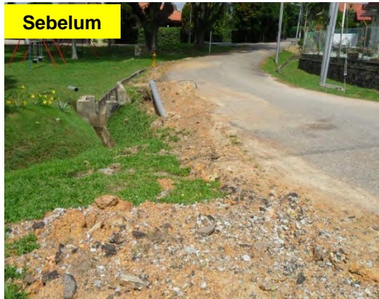
Gambar 2.28 Kerosakan Bahu Jalan Disebabkan Kerja Penanaman Paip Air Oleh SAMB
