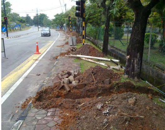
Gambar 2.18 Saluran Air Di Kerb Yang Sedang Dibaiki
