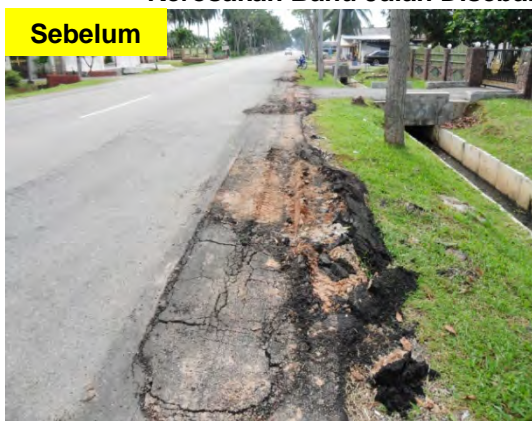
Gambar 2.26 Kerosakan Bahu Jalan Disebabkan Kerja Penanaman Paip Air
