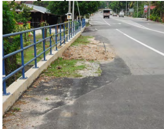
Gambar 2.30 Bahu Jalan Yang Tidak Diturap Mengikut Spesifikasi
