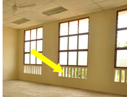
Gambar 3.24 Lubang Laluan Udara Yang Luas Di Bahagian Bawah Tingkap
