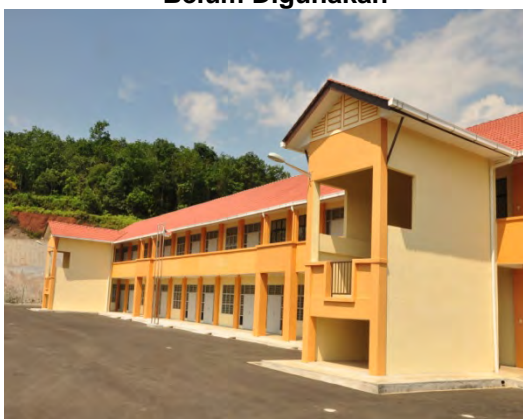
Gambar 3.8 Bangunan Siap Yang Masih Belum Digunakan
