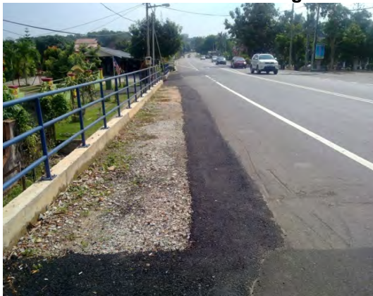
Gambar 2.30 Bahu Jalan Yang Tidak Diturap Mengikut Spesifikasi
